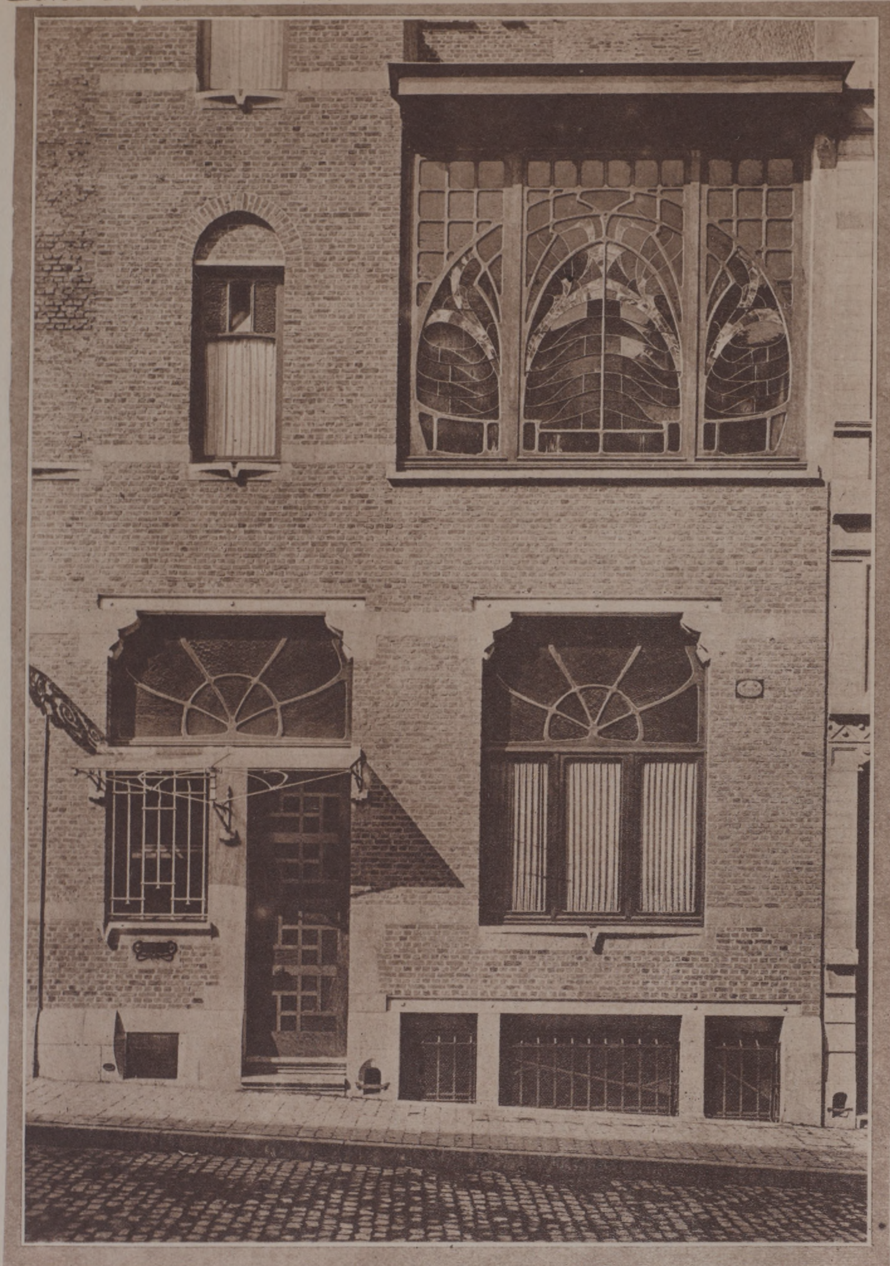
Immeuble privé à Bruxelles 25, rue de Ruysbroeck (Détail de la Façade)
