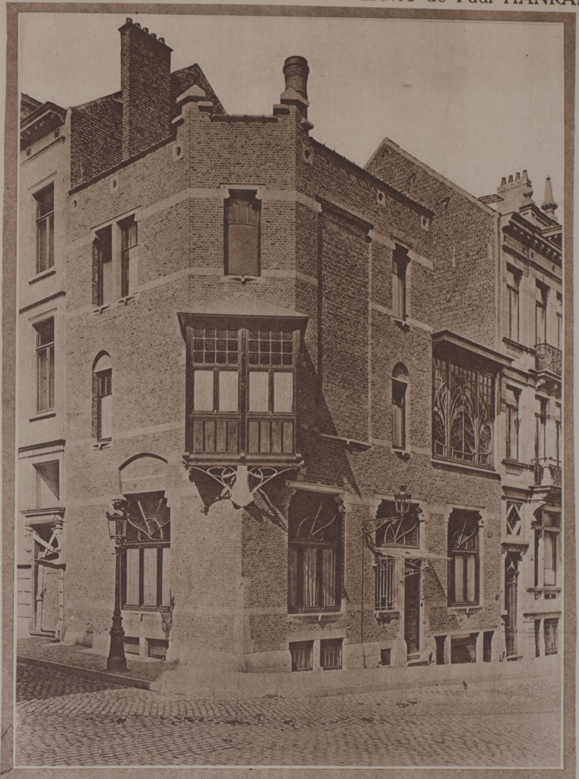
Immeuble privé à Bruxelles 25, rue de Ruysbroeck.
